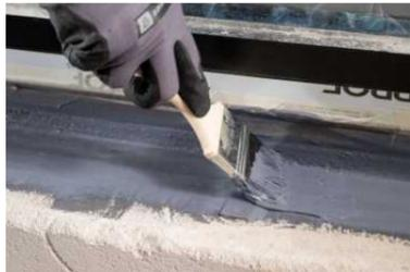
**4.** Нанесите первый слой (примерно 0,5 кг/м²). Второй слой можно наносить, после того как высохнет первый слой (4–24 часа) и изменится его цвет.
