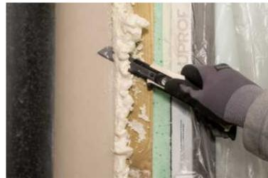
**2.** Предварительно заделайте отверстия и трещины более 3 мм. Излишки полиуретановой пены необходимо срезать перед нанесением герметика.
