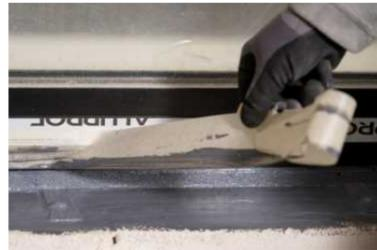
**5.** Малярную ленту следует убрать до отверждения герметика.
