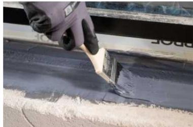
**4.** Kandke pinnale esimene kiht (u 0,5 kg/m<sup>2</sup>). Teise kihi võib peale kanda siis, kui esimene kiht on kuivanud (4–24 h) ja toote värvus on muutunud.
