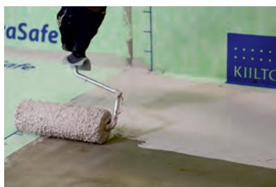
**2.** Alustada KeraSafe+ kanga põrandale paigaldamist samal viisil kui seintele paigaldamist: üksaaval ja vähemalt 5 cm ülekattega.
