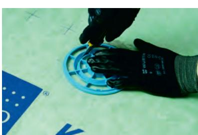
**4.** Pärast kanga paigaldamist tuleb oodata vähemalt 2 tundi enne põrandatrappi jaoks augu lõikamist ja plaatide paigaldamise alustamist.
