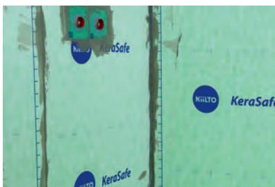
**7.** Pärast viimase kanga kohale asetamist võib kohe alustada plaatide paigaldamist. Plaatide paigaldamist tuleb alustada samast seinast, kust alustati KeraSafe+ kanga paigaldamist.
