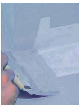
Aseta Välisnurgatugevdus värsele Kiilto Fibergumile ja pintselda üle.
